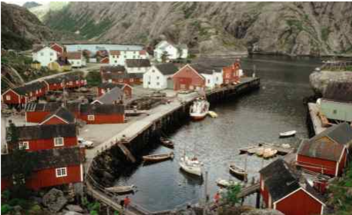
Rorbueene er innvendig pusset opp og innredet for turistene. Nusfjord er ett av pilotprosjektene i "Den verdifulle kystkulturen". Foto Trond Taugbøl©Riksantikvaren.
