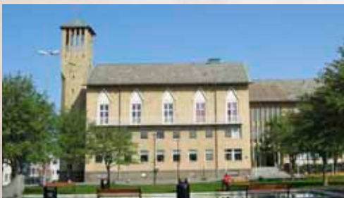
Rådhuset i Bodø. Foto: Bjørn Erik Wøyen ©Riksantikvaren
