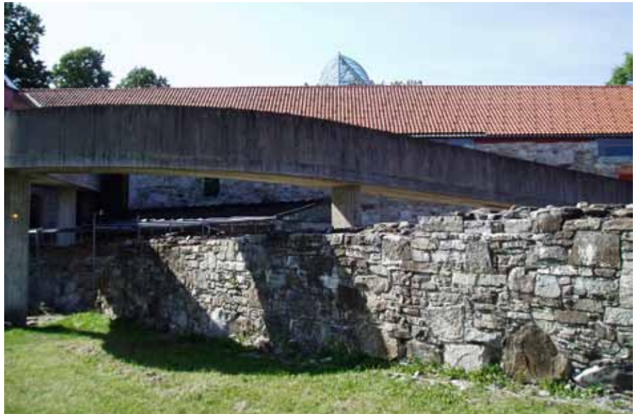
Storhamarläven på Hedmarks museet. Med stor respekt for murene fra middelalderen og driftsbygningen fra 1700-tallet har Sverre Fehn brukt materialer som limtre, rå betong og glass. For sitt arbeide med museumsbygget mottok Fehn en rekke priser. Foto: Åse Bitustøl©Riksantikvaren.
