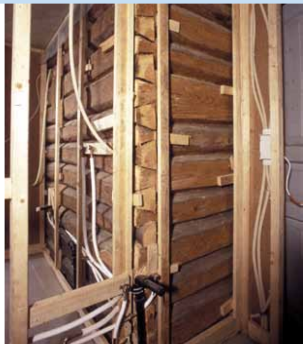
På Fjeldberg prestegård i Sunnhordland er det lagt inn moderne bad. Skal du utbedre eller bygge nytt våtrom i et fredet eller verneverdig bygning, må du søke kommunen om tillatelse til dette. Foto: Kjell Andresen © Riksantikvaren
