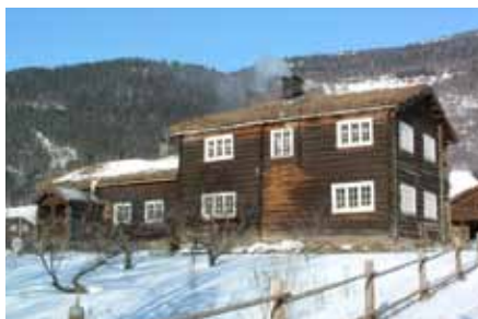
Også på Faukstad i Heidalen biter kulda. Til alle tider har det å holde varmen vært en utfordring. Gjennom århundrer har vedfyring vært løsningen. Foto: Marte Boro ©Riksantikvaren.
