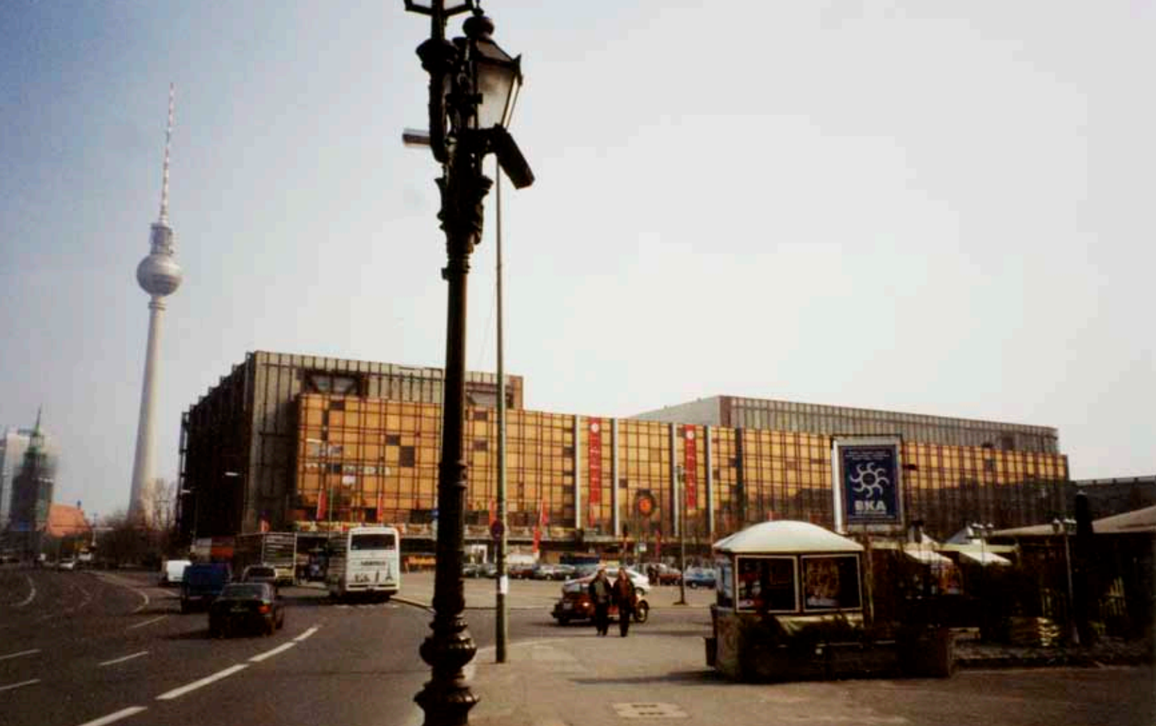
Palast der Republik med TV-tårnet i bakgrunnen. Sammen danner de to bygningene et kjent motiv fra DDR. Dette bildet fra våren 2004 viser at den hvite fasaden på Palast der Republik var fjernet under arbeidet med asbestsanering. Diskusjonen om bevaring pågikk samtidig og bygningen hadde allerede mistet noe av sitt opprinnelige uttrykk. Foto: Geirr Olav Gram
