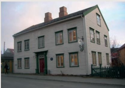
Knudsgården i Tromsø gir eit godt bilete av den tidlege historia til byen med påverknad frå trønderisk og bergensk byggeskikk.
