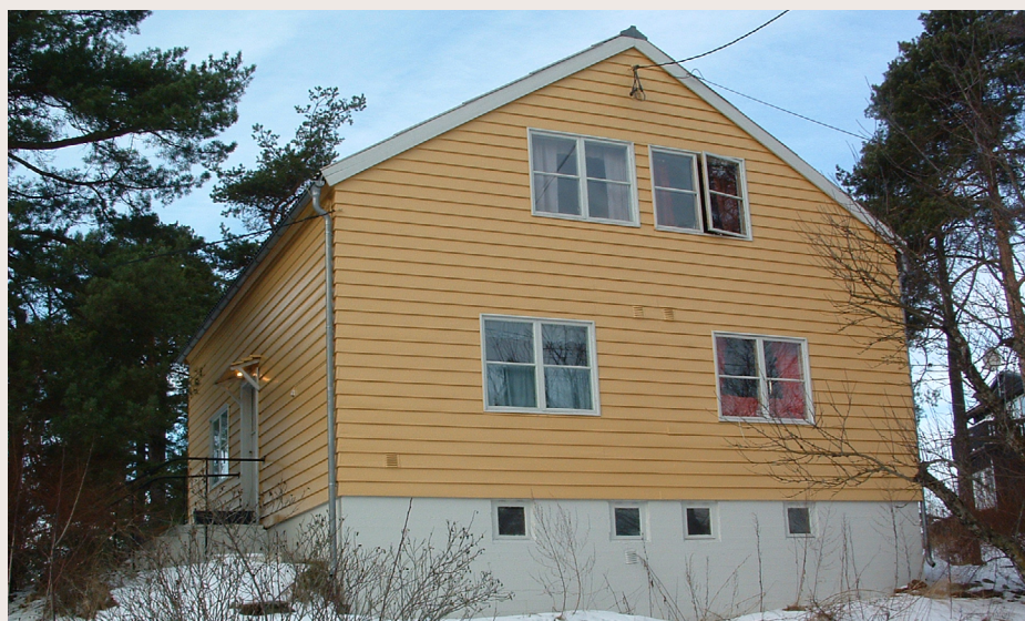
”Selvaaghuset” i Oslo fra 1948 skapte mye diskusjon. Det ble oppført i lett bindingsverk og var på et vis et innlegg i diskusjonen for å få aksept for å bygge i spinklere dimensjoner for å spare både materialer og kroner. Bygningen er fredet etter kulturminneloven på grunn av den tekniske nyvinningen denne bygningen representerte. Foto: M. Boro © Riksantikvaren
