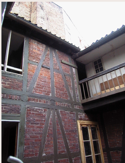
Bakgårdsfasade i utmurt bindingsverk fra midten av 1800-tallet, Oslo. Foto: M. Boro © Riksantikvaren
