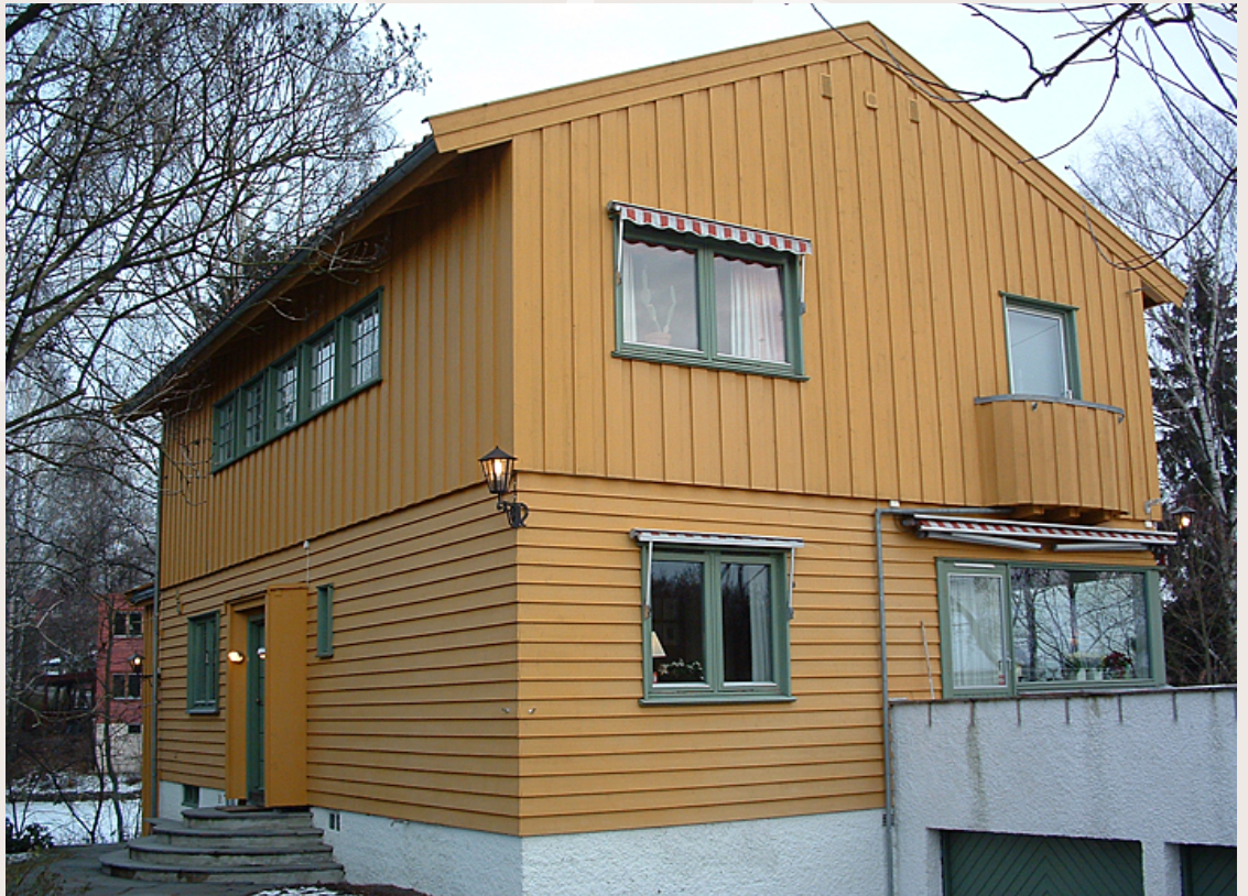
Enebolig oppført i tungt bindingsverk. Foto M. Boro © Riksantikvaren
