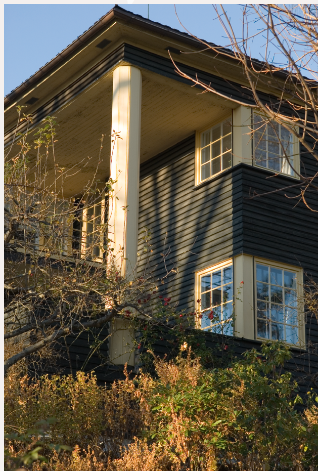
Reisverksbygning i funksjonalistisk stil. Detaljene er viktige for opplevelsen av bygget. Foto: M. Boro © Riksantikvaren
