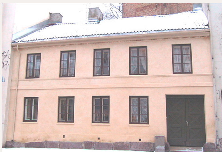
Denne bygningen, som framstår som en ordinær murgård, har tømmerkjerne i 1. etasje. Tømmerveggen er forblendet med pusset tegl i frontfasaden. Inne i portrommet er veggen pusset på en armering av skråstilte hasselkvister. Til venstre vises "tittevinduet" i denne veggen, hvor man ser tømmerveggen på innsida. Oslo. Foto: M. Boro © Riksantikvaren
