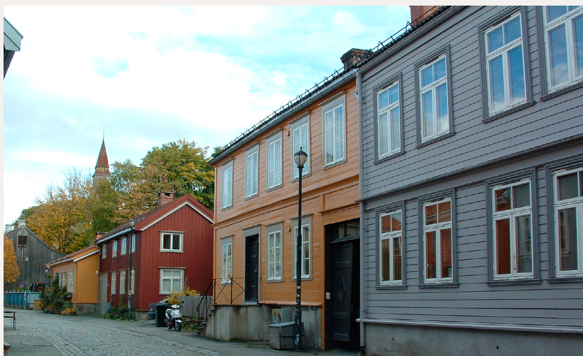
Panelte lafta tømmerhus i bymiljøet på Baklandet i Trondheim. Foto: M. Boro © Riksantikvaren
