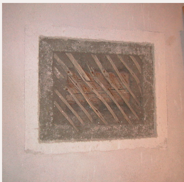
Denne bygningen, som framstår som en ordinær murgård, har tømmerkjerne i 1. etasje. Tømmerveggen er forblendet med pusset tegl i frontfasaden. Inne i portrommet er veggen pusset på en armering av skråstilte hasselkvister. Til venstre vises "tittevinduet" i denne veggen, hvor man ser tømmerveggen på innsida. Oslo. Foto: M. Boro © Riksantikvaren
