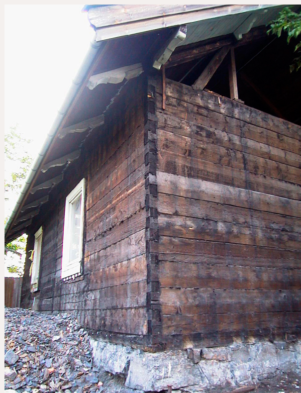
Tømmerhus under restaurering. Panelet er tatt av midlertidig. Legg merke til at gavltrekanter ikke er oppført i laft. Dette er en vanlig løsning.
