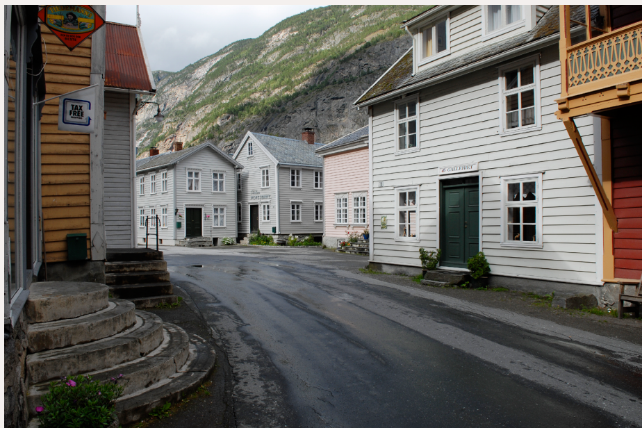
Panelte tømmerhus i Lærdal. Foto: M. Boro © Riksantikvaren
