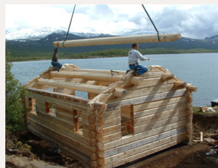
I våre dager er de fleste laftete nybyggene hytter. Laftingen foregår gjerne i større industrihaller og materialene fraktes til tomte og monteres raskt med moderne hjelpemidler. Her sees monteringen av mønsåsen. Foto: Tor Henning Evensen
