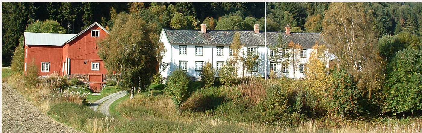
Trønderlandene er svært lange og smale. De er gjerne satt sammen av flere tømmerkjerner ved siden av hverandre. Foto: M. Boro © Riksantikvaren
