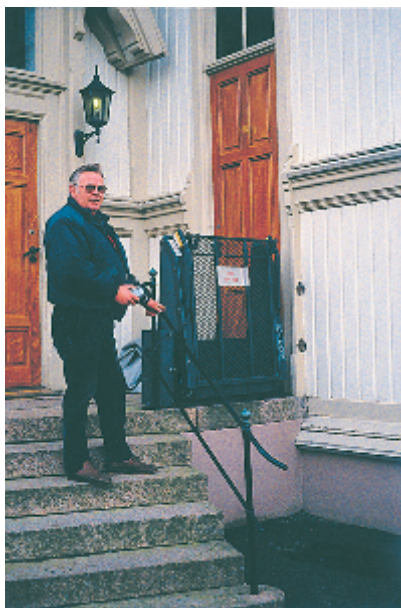
Lillesand kirke har fått en enkel heis plassert ved en sideinngang. Når den ikke er i bruk, står den dekket av en liten presemning som en del av rekkverket. Rekkverket her er som kirken fra 1889, og er en glimrende modell for nye rekkverk. Foto: Eldal, Riksantikvaren 1994.
