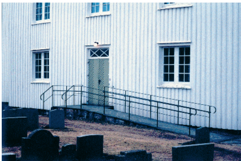
Kvinesdal kirke i Vest-Agder. Rullestolrampe med sideinngang i velvalgte materialer og god håndverksmessig utførelse. Den ekstra, lavtsittende håndlisten er visuelt forstyrrende og har de fleste steder i praksis vist seg lite nødvendig. Den kan derfor sløyfes. Foto: Eldal, Riksantikvaren 1996.
