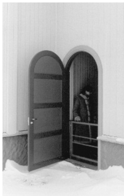
Folldal kirke i Hedmark har fått innvendig rullestolheis av løftebordtype med ny inngangsdør på siden av våpenhuset. Foto: Francine Lampe, Riksantikvaren 1982.
