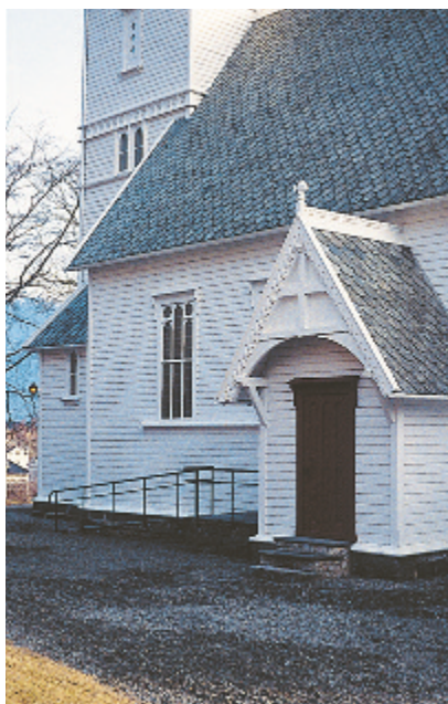
Med ny sidedør ved sideinngangen ble rampen så lite påtrengende som mulig. Enkle former og veltilpasset materialbruk. Utne kirke i Hardanger. Foto: Eldal, Riksantikvaren 1996.
