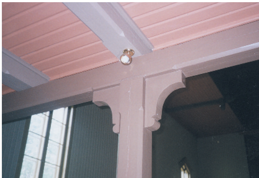
Eksempel på diskret plassering av armatur for belysning av utgangsdør i kirke. Foto: Riksantikvaren.
