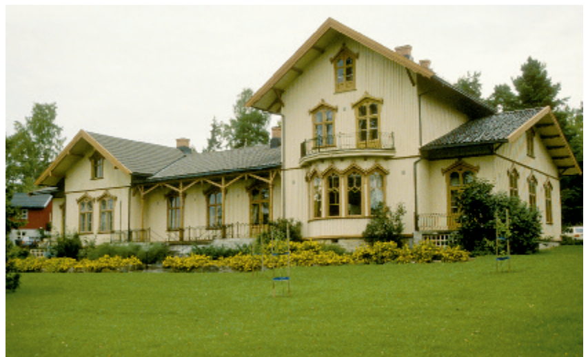
Sagatun i Hamar ble oppført ca. 1865. Også her ser vi den opprinnelige fargesettingen. Foto: Jon Brønne, NIKU.
