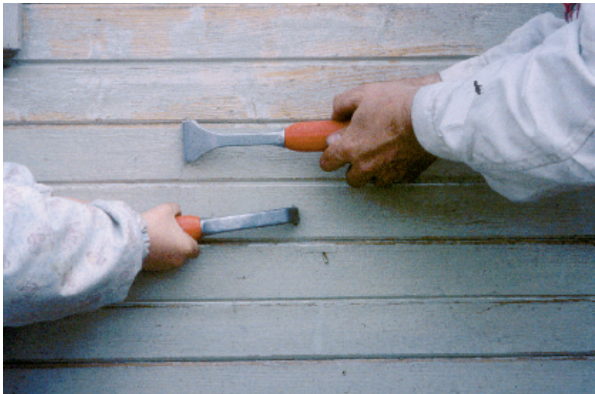
Til skraping bruker vi en stålskraper med skrånstilt, utskiftbare blad. Til profiler bør bladene ha avrundete hjørner. Etter sliping bruker vi stålbørsten. Her gjelder det om å ha sterke armer, for jo større kraft vi bruker, dessto bedre resultat. Skarpe kanter tar vi med sandpapir. Ta tiden til hjelp og husk at et grundig forarbeid gir best resultat. Foto: Jon Brønne, NIKU.
