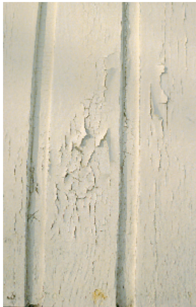
Til venstre: Når linoljemalingen eldes, mister den etter hvert elastisiteten og reagerer med å krakelere, slik dette bildet er et karakteristisk eksempel på.
