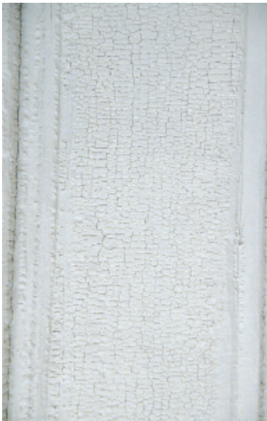
Til venstre: Når linoljemalingen eldes, mister den etter hvert elastisiteten og reagerer med å krakelere, slik dette bildet er et karakteristisk eksempel på.
