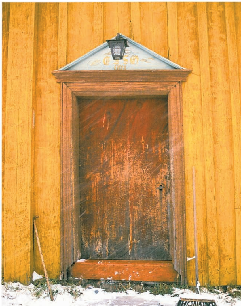
Linoljemaling og komposisjonsmaling er de tradisjonelle eksteriørmalingene på trebygninger her i landet. Her er det oljemalt dør og komposisjonsmalt panel. Foto: Jon Brønne, NIKU.
