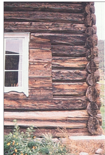
Sydveggen på Snerle i Lalm viser hvor fin en naturlig inntoning blir med årene. De opprinnelige vinduene i huset ble skiftet ut på slutten av 1800-tallet, og de gamle åpningene ble spunset igjen. Foto: Jon Brænne.
