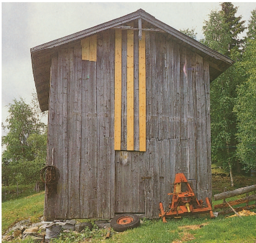
Panelkledd vegg på loft fra Nordre Skafså. Panelet er kun skiftet ut der der var nødvendig for å unngå skade på veggen innenfor Foto: Birger Lindstad, NIKU.
