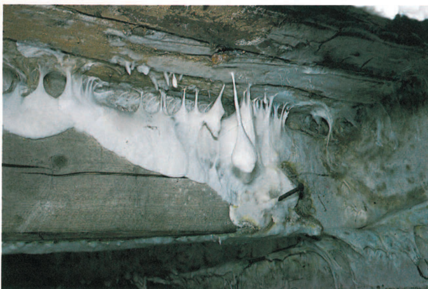
Ekte hussopp. Vi ser mycel på gulvbjelke i en fuktig krypkjeller.
