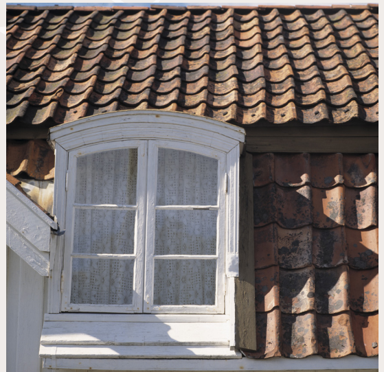
Et gammelt teglsteintak gir en levende overflate som nyere tekkingsmaterialer med mer eller mindre hell forsøker å kopiere. Fra Lyngør. Foto: Arve Kjersheim © Riksantikvaren
