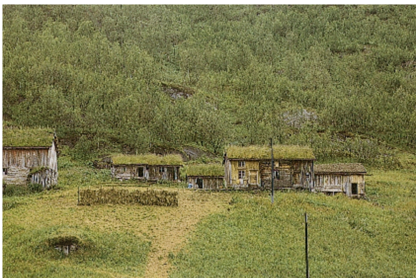
Alle bygninger vil være påvirket av det miljøet som omgir dem. Det er i hovedsak det naturlige klima som styrer miljøpåvirkningen.
