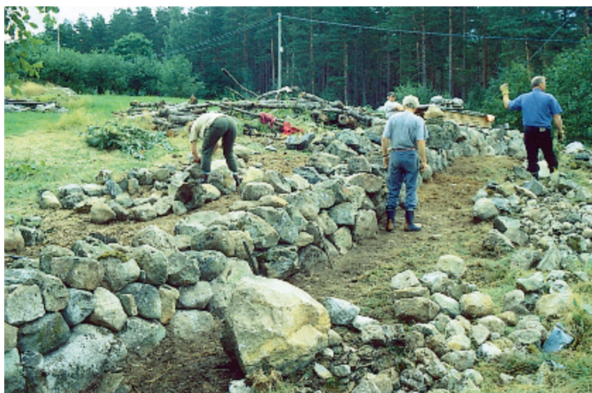
Vedlikehold og utbedring av steingjerder krever tålmodighet og omtanke. En ryddig arbeidsplass letter arbeidet. Når muren tas ned, sorteres steinen. Tilkjørt stein legges i passende avstand fra gjerdet, slik at den er lett å hente.
