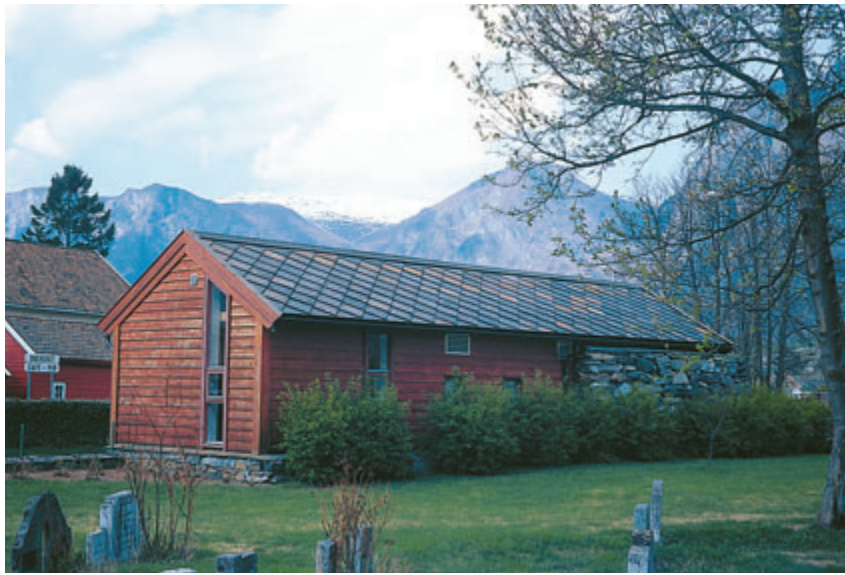
Ved bygging av nytt bårerom og kirkestue på Aurlandsvangen i Sogn i 1990, fikk man re- vet en skjemmende transformatoriosk som sto der fra før. Det vellykkete resultatet skyl- des en gjennomtenkt kombinasjon av tradisjonelle Vestlandsformer, velvalgte materia- ler, fargesetting og beplantning. Arkitektene Hansteen A/S. Foto: Eldal, NIKU 1996.
