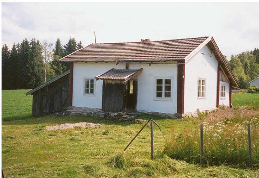
Fredingar frå 1920-talet av hus på landsbygda omfatta storgardar med hovudvekt på anlegg i dalføra på Østlandet. Tida var ikkje moden for å dokumentar bustadar og levevilkår til husmenn. Av dei få husmannsplassar som er tatt vare på finn vi Hesthagen, Ringsaker i Hedmark. Husmannstova er oppført i rappet tømmer. Foto: Toril Sættem Vestad. Riksantikvaren.
