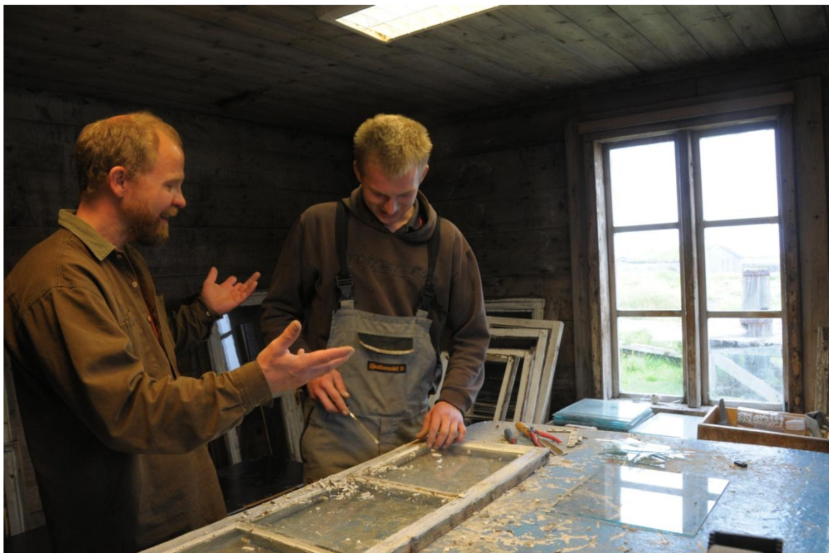
Foto: Marit Bendz. Håndverkere istandsetter vinduer.
