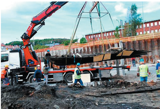
Batteristranda 2007. Flytting av skipsrest fra 1700-tallet. Foto: Østlandsposten.
