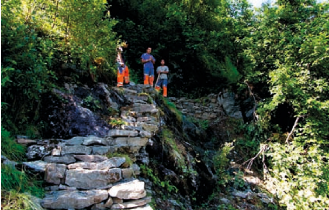
Sherpaer frå Nepal under arbeidet på Rimstigen 2010 Foto: NVP
