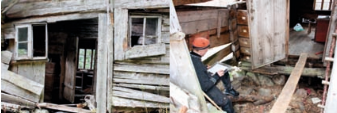
Skogastova før demontering. Foto: NVP
