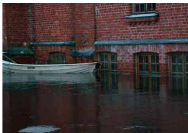
Oversvømt fabrikkbygning, Verla. (Foto: Pertti Peltola, Verla Mill Museum)
