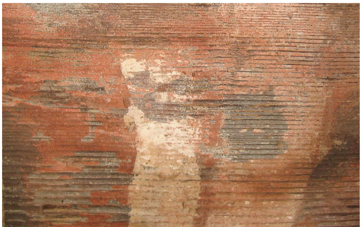
Fig. 18: Samme område som ovenfor etter at overskuddet av lim er blitt fjernet. Foto: NIKU 2009.
