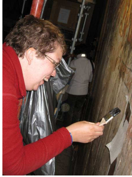
Fig. 19: Størlimet løses i vann og varmes opp til ca 45°. Foto: NIKU 2009.
