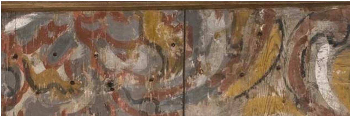
Fig. 7: Plugghuller i sikksakkmønster på sørvegg i koret. Hullene stopper i området over døren, til høyre i bildet. Foto: Birger Lindstad, 2008.
