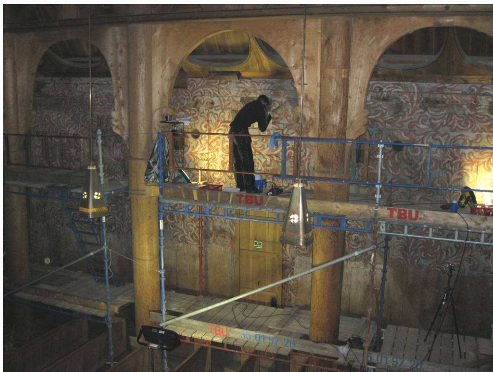
Konsolidering av limfargedekor på sørvegg i skipet. Foto: NIKU 2009.
