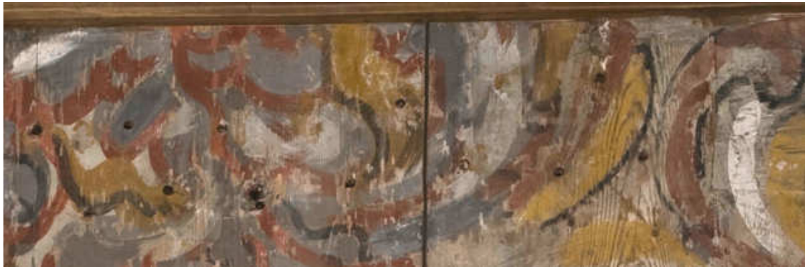
Fig. 1: Plugg huller i sikksakkmønster på sørvegg i koret. Hullene stopper i området over døren, til høyre i bildet. Foto: Birger Lindstad, 2008.
