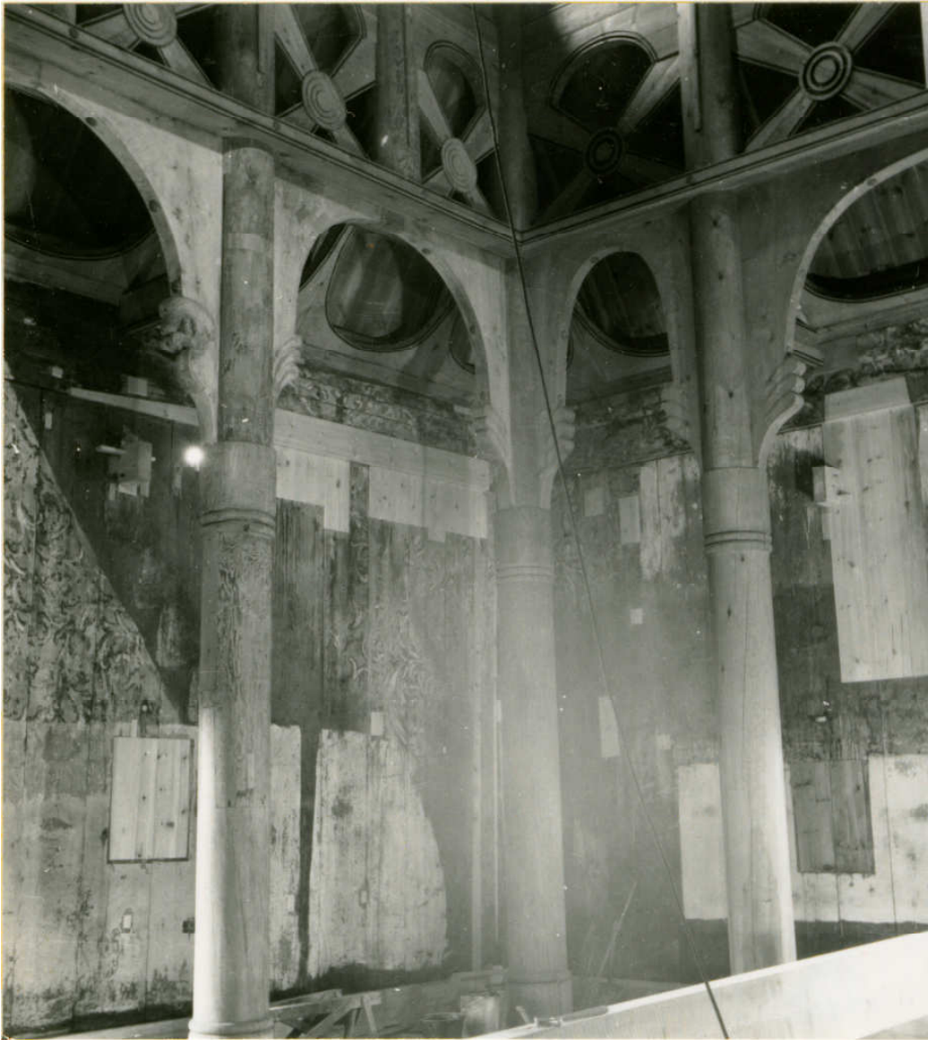
Fig. 2: Foto tatt mot sørvestre hjørne. Negative fargespor etter trapp på sørvegg. På fotografiet ser man også den omfattende innspunsingen som ble foretatt ved restaureringen 1930 – 1955. I nedre venstre del av bildet ser man hvitkalkingen av nedre del av veggen. Foto: Sæter 1954, Riksantikvarens arkiv. 1
