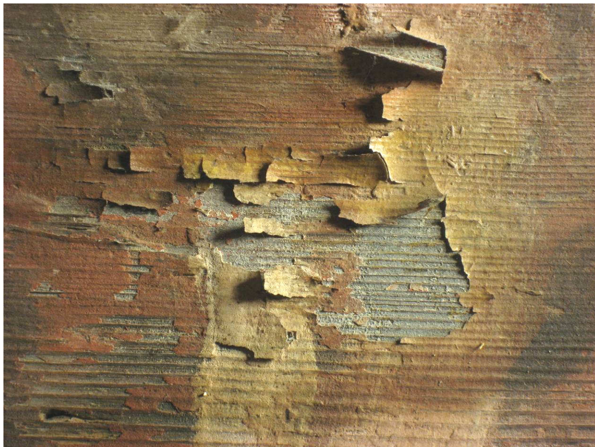
Fig. 17: Oppskalling i malingen som skyldes overskudd av lim på malingens overflate. Overskuddet viser seg som blanke, misfargede områder. Stavleggje, vestvegg. Foto: NIKU 2009.
