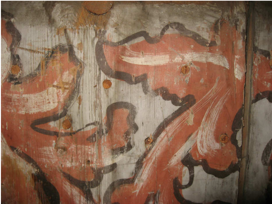
Fig.2: Detaljopptak av plugg i sikksakkmønster rett under stavleggja på nordre del av vestveggen i skipet. Foto: NIKU, 2009.
