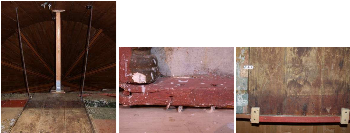
Figur 44. Altertavlen i Hedalen stavkirke. Demonteringen 2005: Til v.: altertavlens bakvegg var festet til korveggen med to jernstenger og en treplanke (bildet er tatt fra gulvet opp mot taket). Samme metode ble brukt ved remontering 2007. I midten: To spikre var slått gjennom nedre list på sidefløyen mot syd og ned i alteret. Disse ble saget over. Til h.: Ved remontering ble støtteklosser skrudd til alterbord og bakvegg. Samtidig ble hengslingen mellom bakvegg og fløyer forsterket med ekstra hengsler. Foto Merete Winness, NIKU, 2005, 2007
