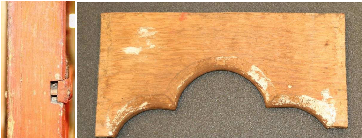
Figur 9. Listene som deler fløyene inn i etasjer er skjøtet inn i listene på fløyenes sidekanter. Arkadebuene er skåret separat. Foto: Mille Stein, NIKU, 2006.
