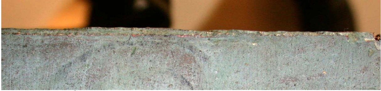
Figur 13. Øverst på bakveggen avsluttes den originale malingen litt innenfor kanten og i et litt tykkere lag enn nedenfor. Penselen har støttet mot en kant e.l. da bakveggen ble grundert og malt. Under den blå overmalingen – som fortsetter ut over øvre kant – skimtes et rødt malinglag. Foto: Mille Stein, NIKU, 2007
